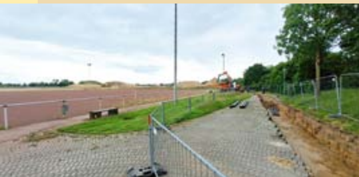
Im Sportzentrum Berliner Allee 53 haben zurzeit die Bagger das Sagen. An dieser Stelle entstehen zwei neue Fußballplätze.
