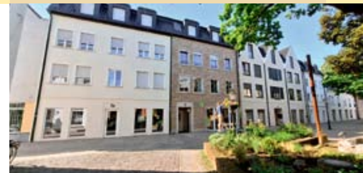
Das Neubau-Ensemble Ellenstraße 11-14 schmiegt sich harmonisch ins Altstadtbild ein und zeigt hochwertige aufgelockerte City-Architektur.
