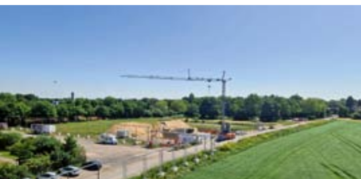
Vom Dach des künftigen Haus Thomas am Schmeddersweg zu sehen: die Baugrube für das erste von fünf Penthäusern ist ausgehoben.
