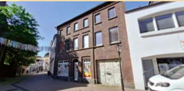
Wildplakatierer und Graffiti-Schmierer verunzieren aktuell das Haus Judenstraße 15. Der Backsteinbau wird demnächst saniert.
