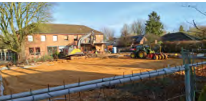
Blick über den Bauzaun: der Kita-Neubau „Kleine Hände“ wird in Angriff genommen.
