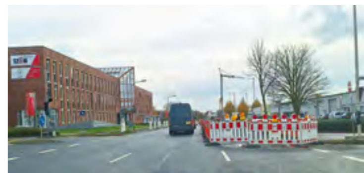
Die Baustelle Industriering Ost mit Netzwerkarbeiten zieht sich bis ins Frühjahr 2025.
