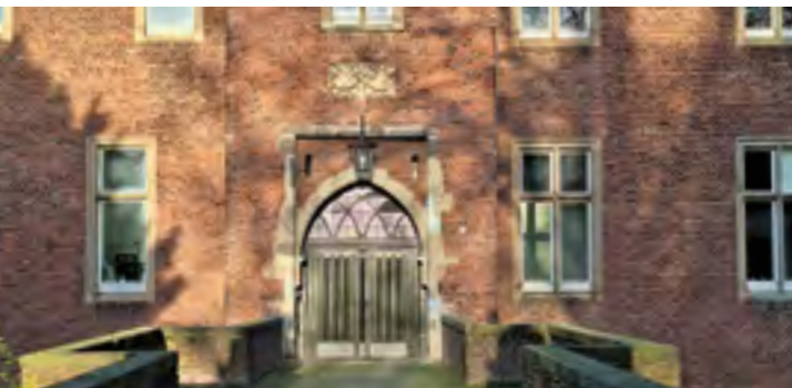
Das alte Mauerwerk am Burgportal ist von der Stadt ausgebessert worden.
