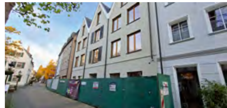
Ein attraktiver Neubau auf der Ellenstraße anstelle der alten Von-Broich-Passage.
