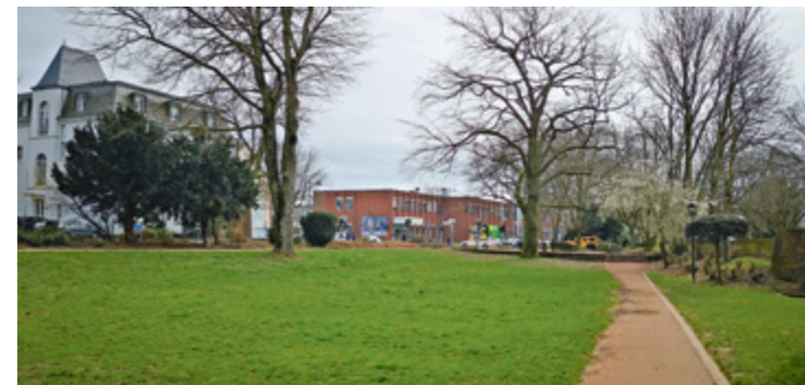
Die frühere Post am Moorenring wartet auf die Abrissbirne.
