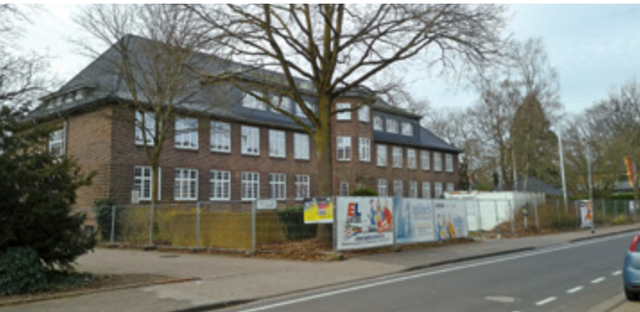
Die Entkernung der rund 100 Jahre alten früheren Martinschule ist fast fertig.
