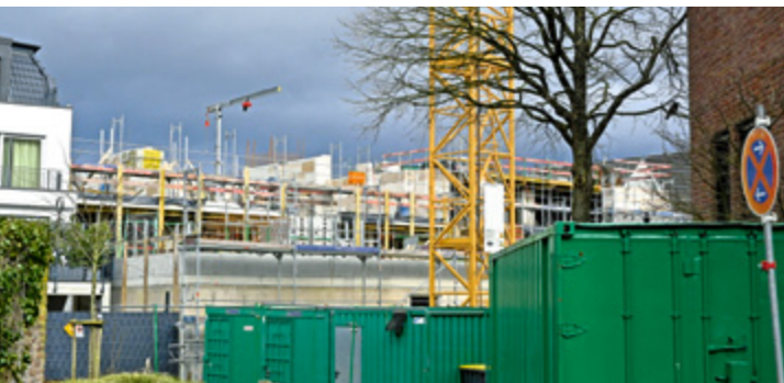
Auf dem Grundstück Ellenstraße 11-14 macht der Neubau Fortschritte.
