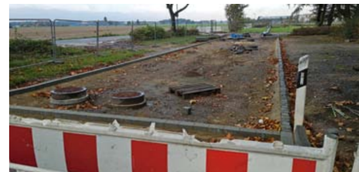
Die Kanalarbeiten am Schmeddersweg sind so gut wie abgeschlossen.
