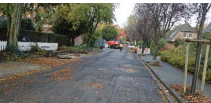
Der Heyerdrink ist wegen Straßenbauarbeiten ein Nadelöhr.
