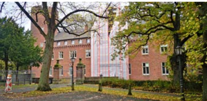
An der Burg wird an der Fassade gearbeitet.
