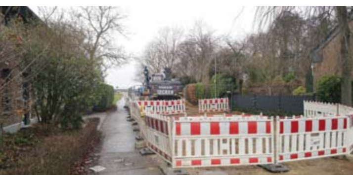
Am Schmeddersweg laufen Kanalbauarbeiten zur Erschließung von Kempen-West.
