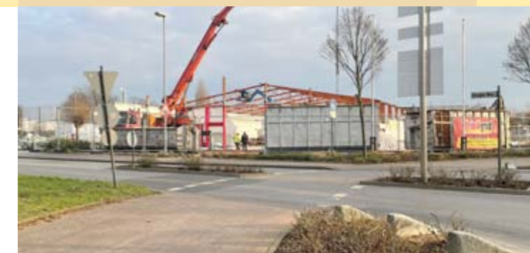
Der trinkgut-Markt an der Kleinbahnstraße wird abgerissen und größer neugebaut.
