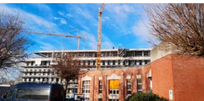
Der Hospital-Neubau schießt in die Höhe.
