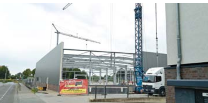
Von Materialengpässen keine Spur: der trinkgut-Neubau macht Fortschritte.
