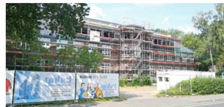
Die frühere Martinschule wird saniert, die Gesamtschüler müssen sich gedulden.
